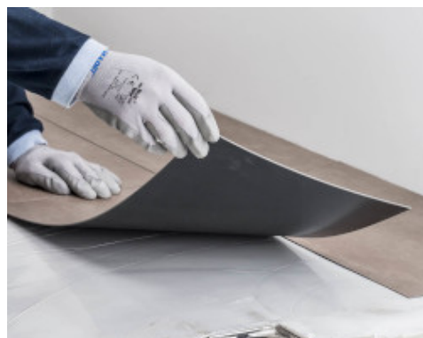
posa di LVT a pavimento con Ultrabond Eco MS 4LVT Wall&Floor in ambienti umidi
