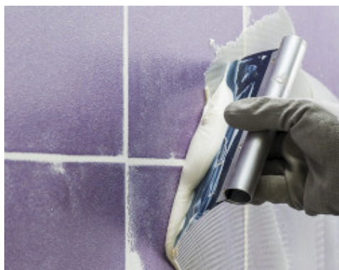
Stesura di Ultrabond Eco MS 4LVT Wall&Floor su supporto non assorbente con spatola dentata
